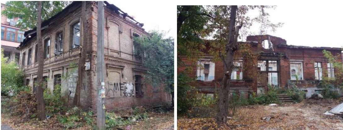
Рис.4.1, рис. 4.2 Фотографії будівель на ділянці проєктування [11],[12]
