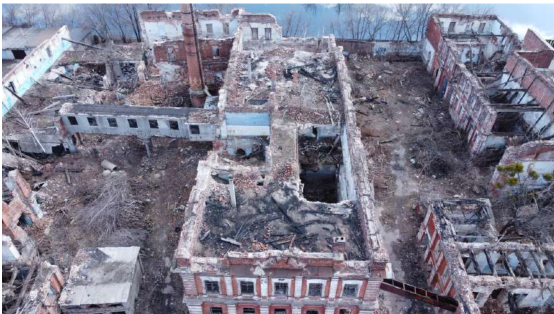
Рис. 3.2 Стан будівлі на лютий 2021 року
